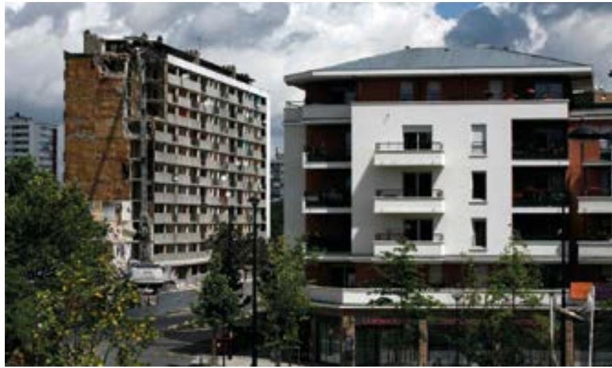
Le B1 en cours de démolition, vu depuis la Place Notre-Dame-des-Anges.
