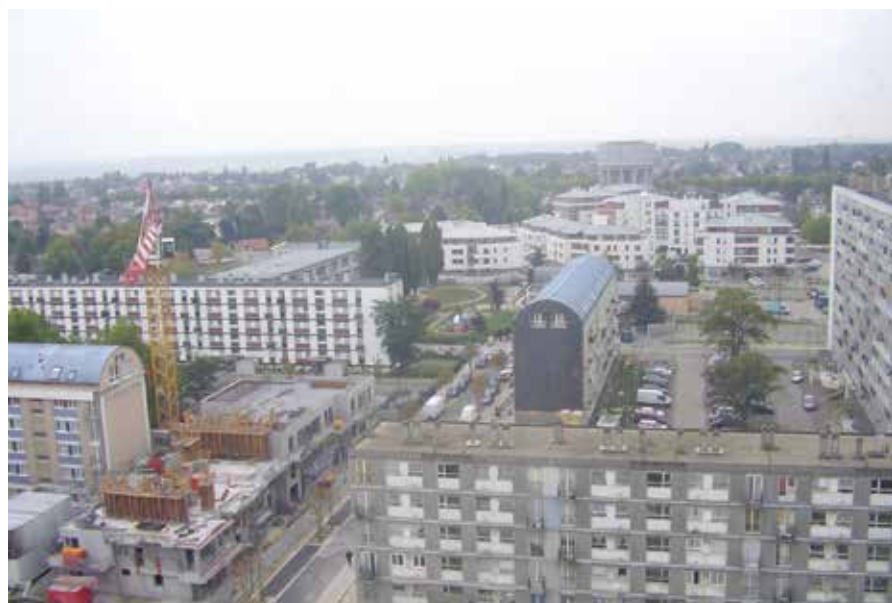
Le quartier Bosquets pendant les travaux du PRU (Plan de rénovation urbaine).
