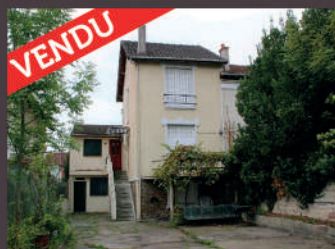
MONTFERMEIL Secteur : Barrière Blanche
