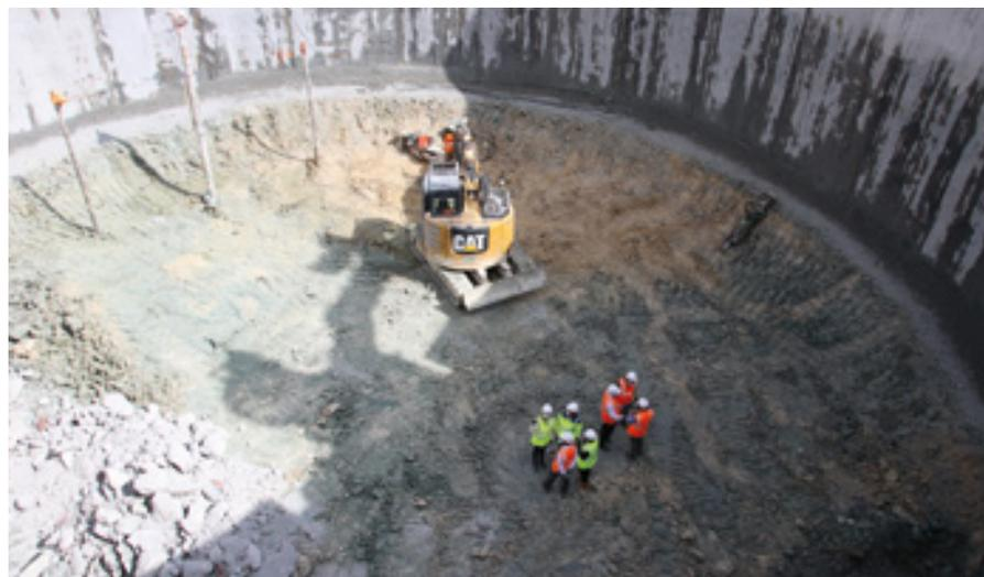
Au terme de la phase de terrassement, le trou creusé sera d'une profondeur de 26 mètres.
