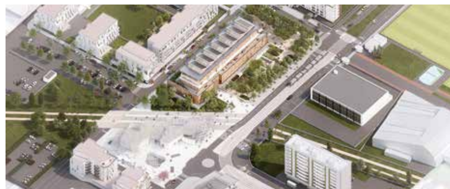
Vue aérienne des futurs Ateliers Médicis, à proximité immédiate de la future gare de la ligne 16 « Clichy-Montfermeil ».
