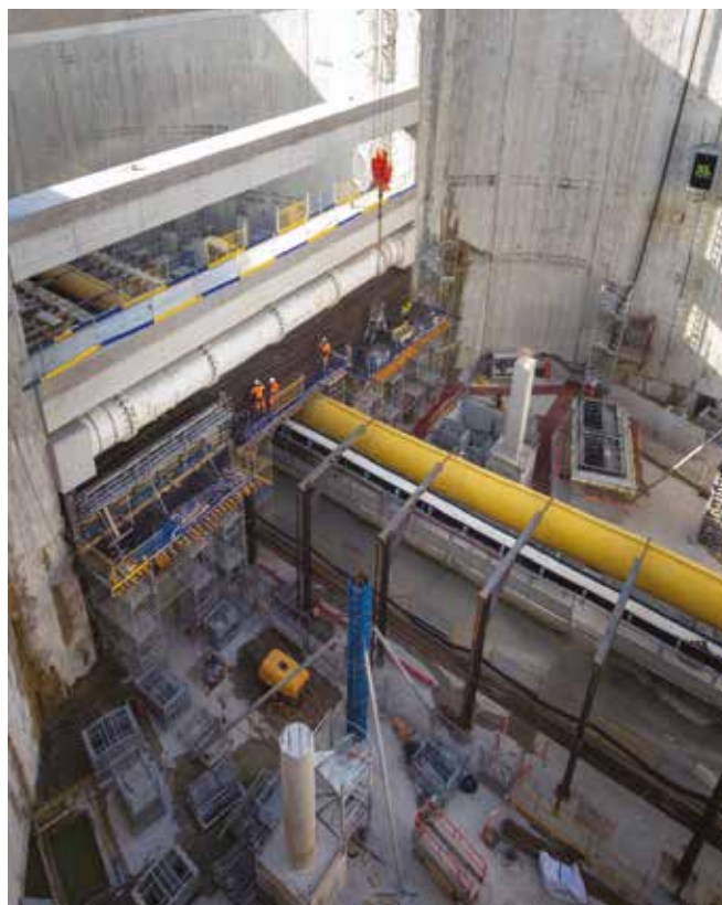
Depuis le ripage (après percement, déplacement du tunnelier d'une extrémité à l'autre de la gare) du tunnelier Mireille au printemps dernier, la construction des premiers niveaux souterrains a débuté. Photo : septembre 2022
