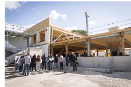
Travaux de l'école maternelle Jules Ferry
