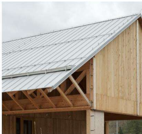
Zinc et structure bois apparente
