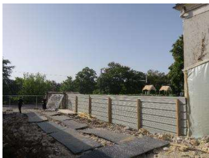
La parcelle C273 en cours de démolition
