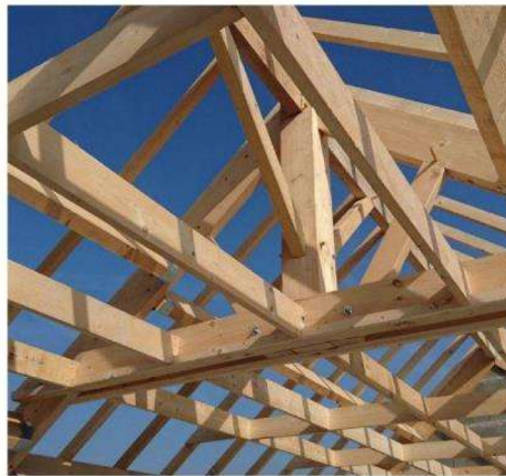
Charpente en bois
