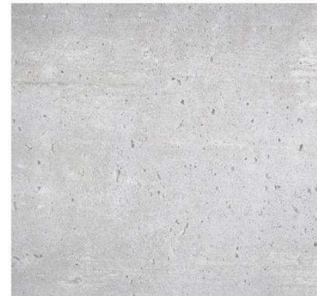
Béton apparent à l'intérieur
